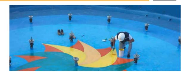
Impermeabilización de poliurea **TECNOCOAT H-2049** para cubiertas
